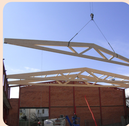
Instal·lació de les primeres encavallades de la coberta
