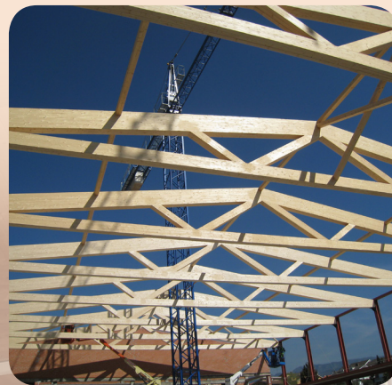
Encavallades de la coberta un cop instal·lades
