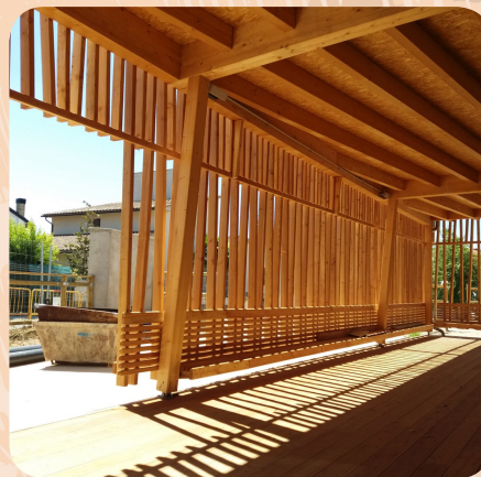
Vista interior de l'estructura d'entramat lleuger
