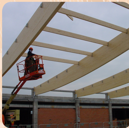
Instal·lació de les bigues de la coberta
