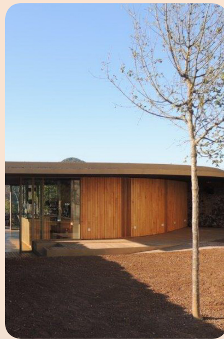
Edifici de fusta destinat a restaurant i cafeteria
